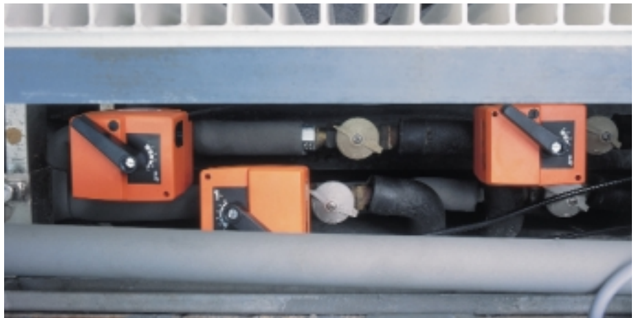
Kompakt, robust und zuverlässig: Die neuen motorisierten Regel-Kugelhähne von Belimo ersetzen herkömmliche pneumatische Hubventile
