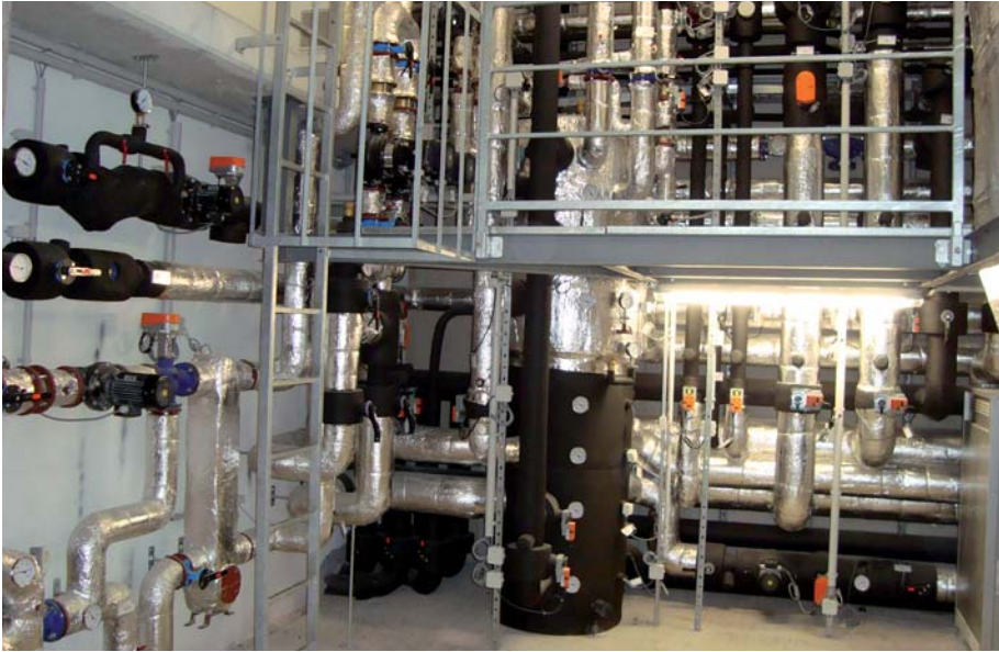
Technikzentrale mit Belimo-Ventilen und Stellantrieben, jeweils mit Sensoreinbindung über MP-Bus
