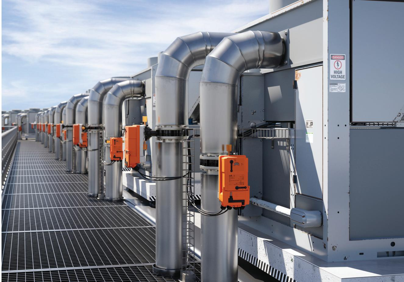
Las Válvulas de Mariposas son componentes fundamentales en los sistemas hidráulicos. Desafortunadamente, la mayoría de las válvulas de mariposa están lejos de ser ideales. Tienen fugas, sus tiempos de funcionamiento no son los óptimos para los sistemas de climatización, son pesadas, el acceso al cableado se torna difícil y no pueden ponerse a operar rápidamente.
