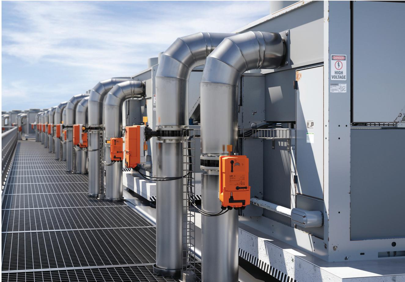
Válvulas Borboleta são componentes fundamentais em sistemas hidrônicos. Infelizmente, a maioria das válvulas borboleta é inferior ao ideal - elas vazam, seus tempos de funcionamento não são otimizados para aplicações HVAC, são pesadas, seu cabeamento é de difícil acesso, e sua operação não pode ser iniciada rapidamente.
