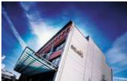
Der Hauptsitz von Belimo befindet sich rund 30 km von Zürich entfernt in Wetzikon und Hinwil (Bild: Produktions- und Vertriebszentrale Hinwil)
