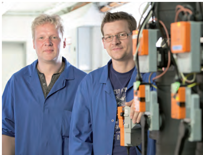
Günter Wilmlink (li.) und Kristian Fitzner vom Haustechnikteam sind begeistert vom Einsatz der Energieventile.
