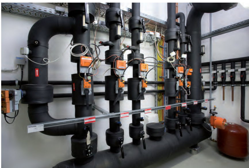
Die Belimo Energy Valves vereinen Volumenstrommessung, druckunabhängige Regelung, automatischer hydraulischer Abgleich, luftblasendichte Schließung und Monitoring.
