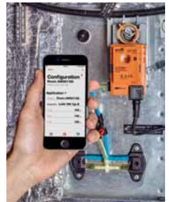
Konverter „Bluetooth zu NFC“ für die drahtlose Bedienung von Belimo-Geräten mit NFC-Schnittstelle
