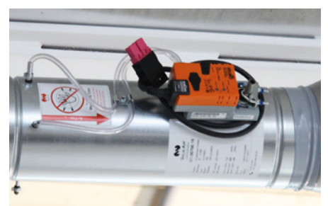
VAV Compact mit kundenspezifischer Kabellänge und Wago-Stecker – Plug and Play.
