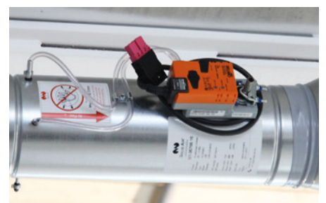
VAV-Compact met klantspecifieke kabellengte en Wago-connector – 'plug and play'.
