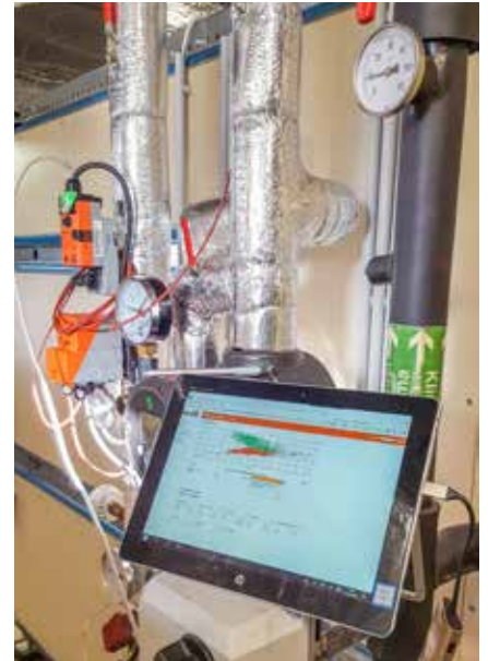
Analyse der aufgezeichneten Daten zur Optimierung von Delta T und des V_{max} -Wertes in der Dachlüftungszentrale.
